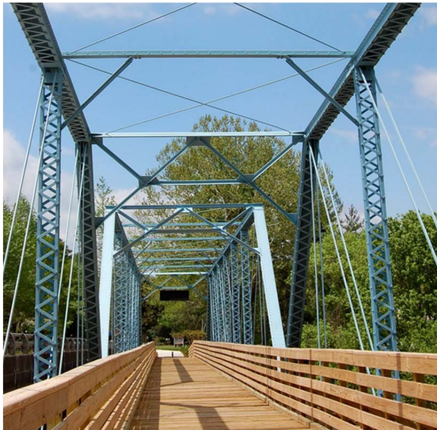
(d) View from the bridge deck
